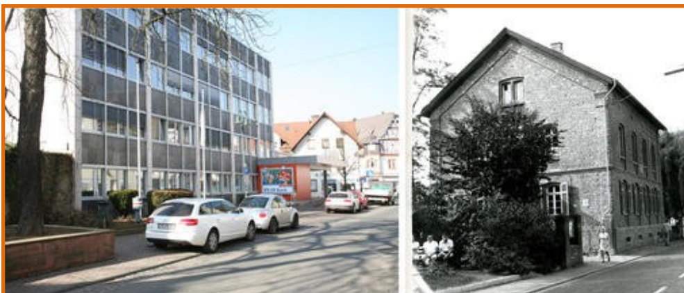
Auf der „Innenstadtinsel“ zwischen Marktstraße und Teichstraße hat die VR Bank nach dem Abriss ihre Gebäude errichtet (links). Vor 40 Jahren fiel der Beschluss, das alte Forstamt in der Marktstraße abzureißen, Anfang 1971 rückten die Bagger an (rechts). © Hartmut Berge / Bildarchiv Heimatverein Gladenbach
