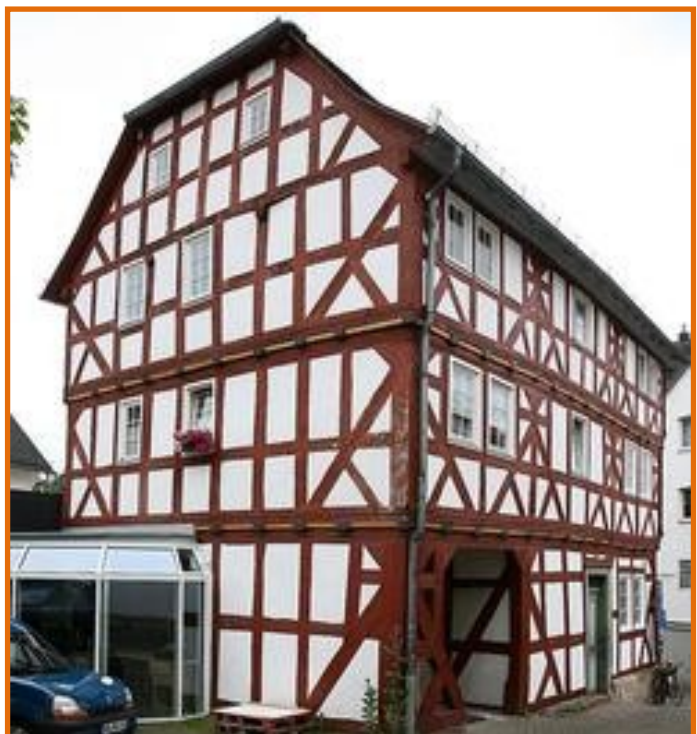
Als stolzer Fachwerkbau präsentiert sich der Mönchshof heute. © Hartmut Berge
