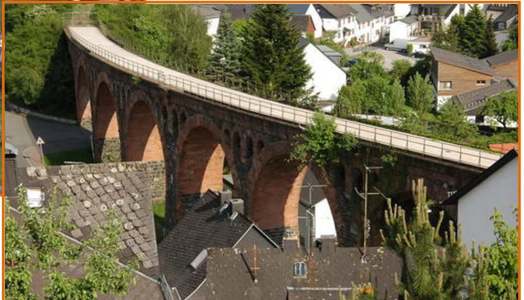
In gleicher Bauweise wie das Viadukt in Bad Endbach entstand die Brücke über das Schlierbachtal in Hartenrod. © Tobias Hirsch
