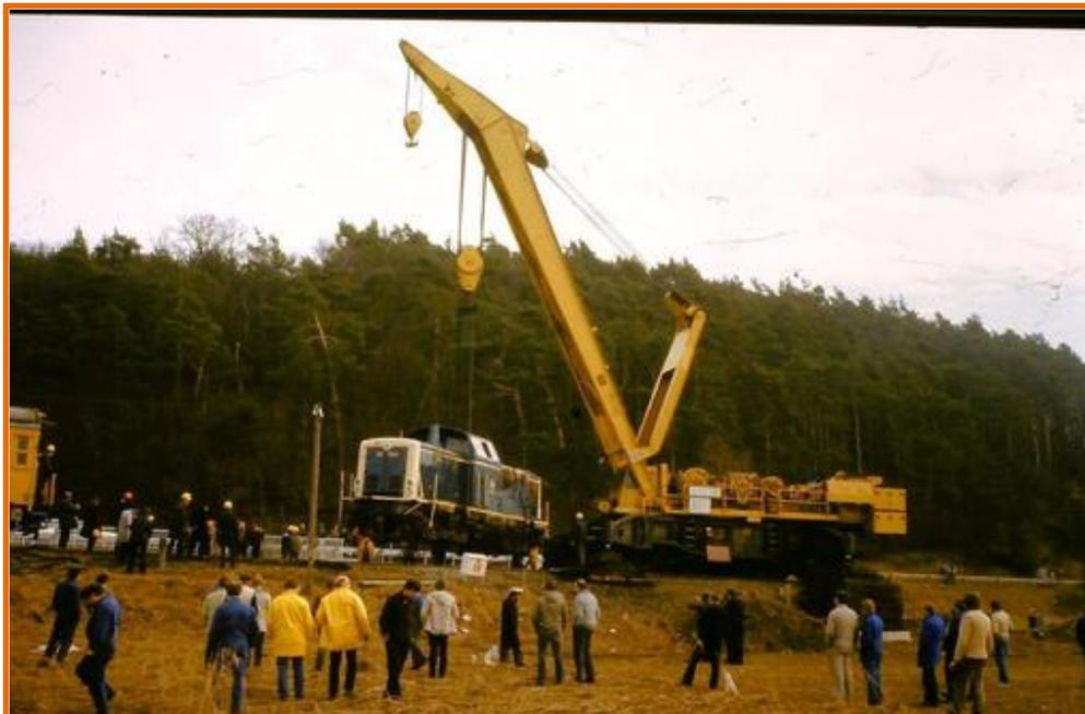
*Die Lok hängt am Kran und schwebt auf das Gleis zurück. Rechts unter den Gegengewichten des Krans erkennt man dessen Stützen, die sich auf Schwellenstapel auf extra gebauten Stahlbetonfundamenten abstützen.*
